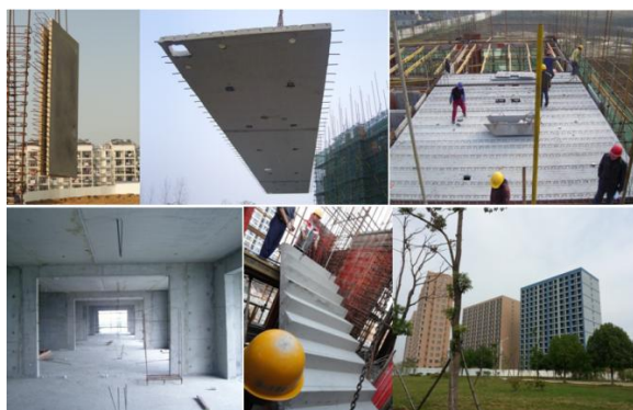
装配式混凝土工业化现场
