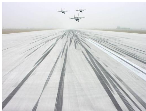
应用高性能混凝土建设的空军某机场道面
